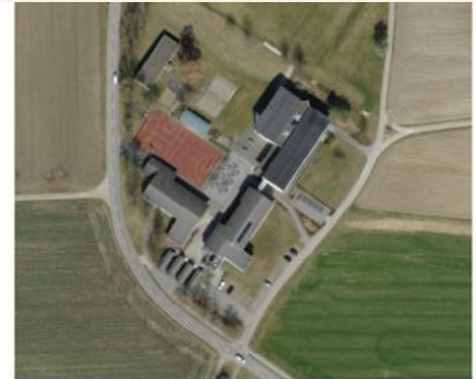
Luftaufnahme aktuell M: 1:2000 (Quelle: ThurGIS)
